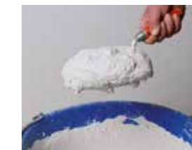
richtige Konsistenz des Lehm-Finishputz als Veredelungsschicht
