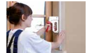
Eckwinkel montieren
