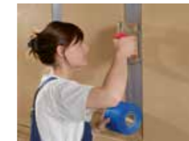
Fugenarmierungsgewebe in Flachkanten eintackern
