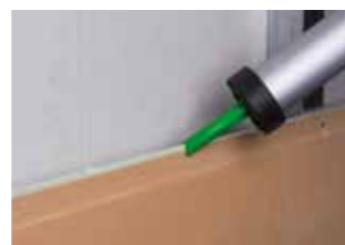
Kantenkleber aufbringen
