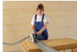
Zuschneiden der Platten
