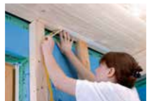
Dichtungsband/Trennlagenpapier ankleben
