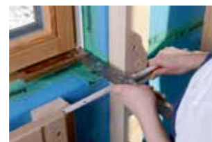
Anschlussplatte ausmessen
