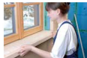
Fenstersims einsetzen
