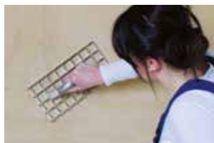
Fläche mit Lehmputz-Spezialrobot egalisieren
