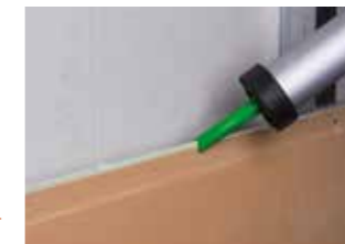
Kantenkleber aufbringen
