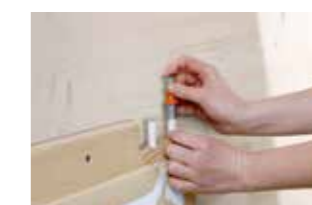
Presskupplung ganz aufsetzen
